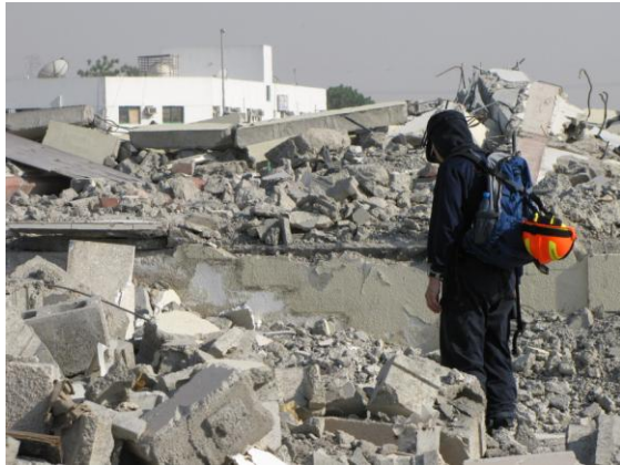
De bouwkundige beoordeelt de situatie
